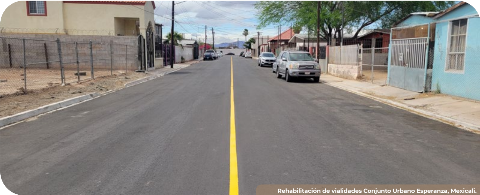
Rehabilitación de vialidades Conjunto Urbano Esperanza, Mexicali.
