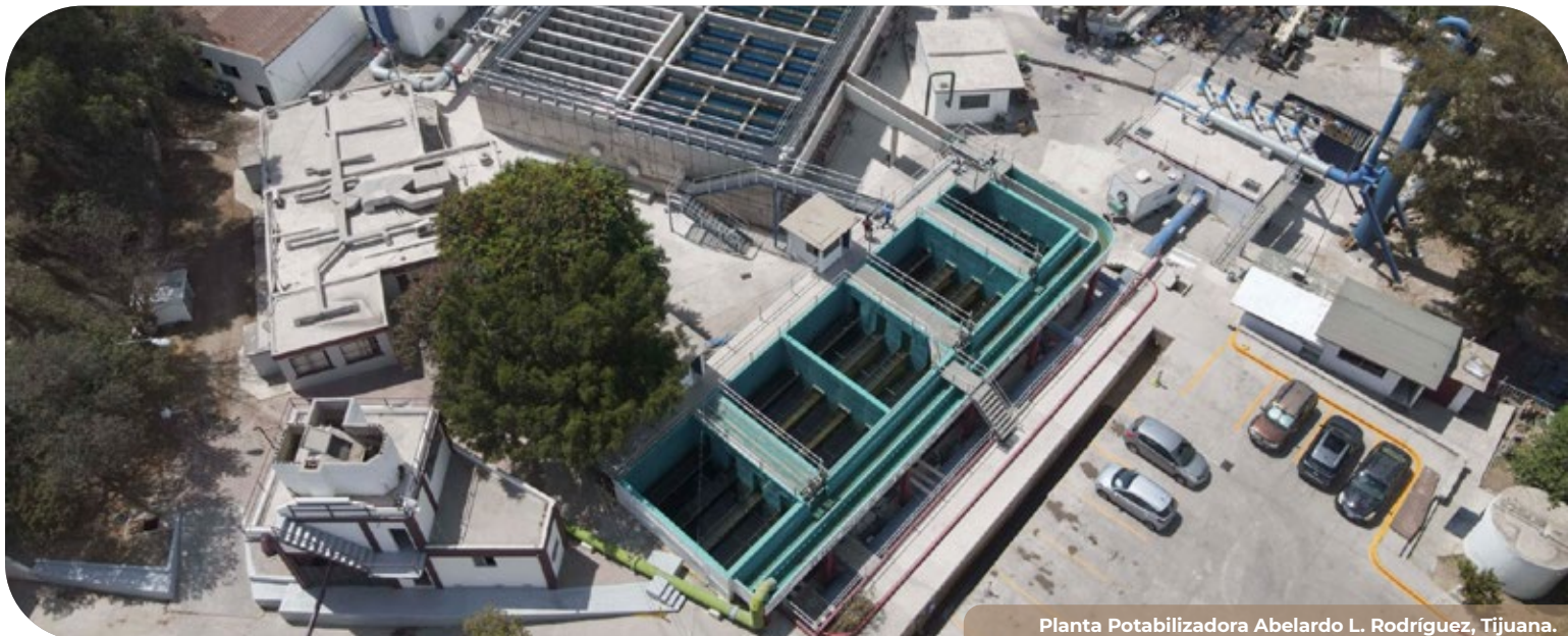
Planta Potabilizadora Abelardo L. Rodríguez, Tijuana.
