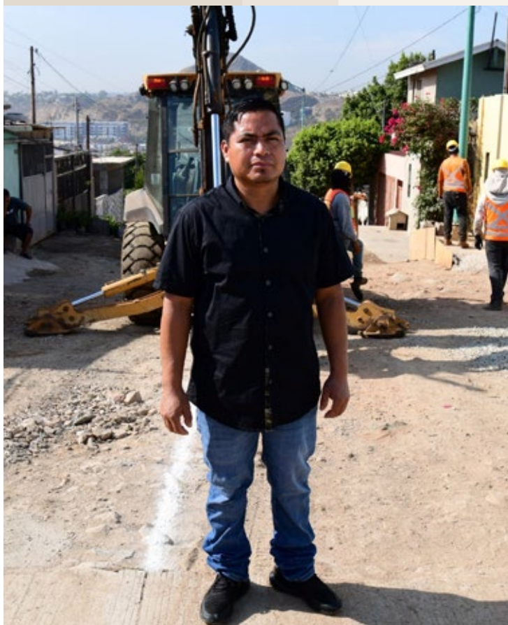
Julio César Chilel Colonia Granjas Familiares, Tijuana. Beneficiado con obra de alcantarillado sanitario.
