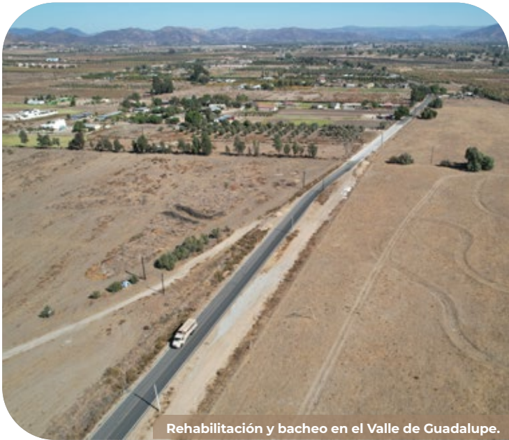
Rehabilitación y bacheo en el Valle de Guadalupe.
