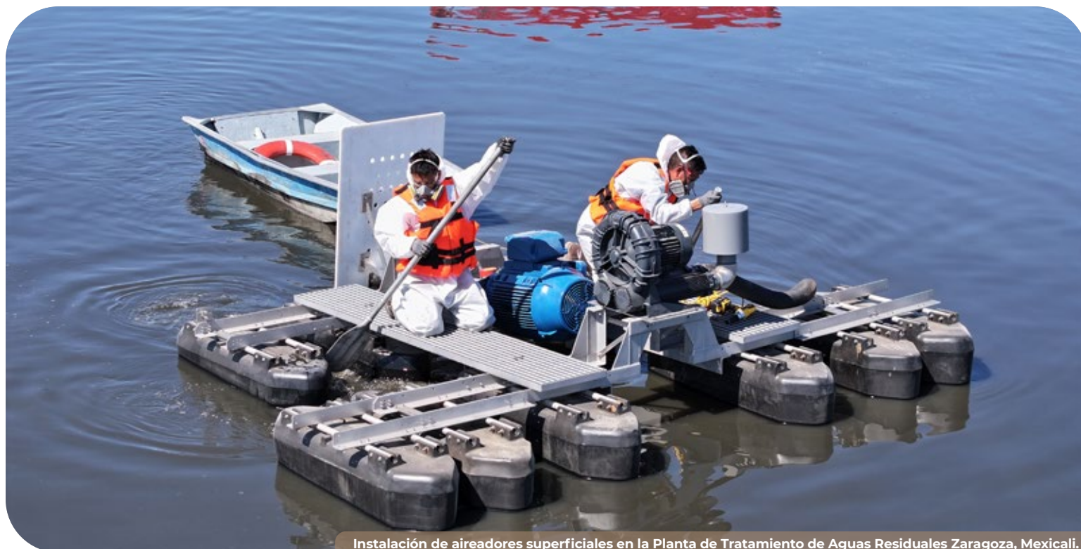
Instalación de aireadores superficiales en la Planta de Tratamiento de Aguas Residuales Zaragoza, Mexicali.
