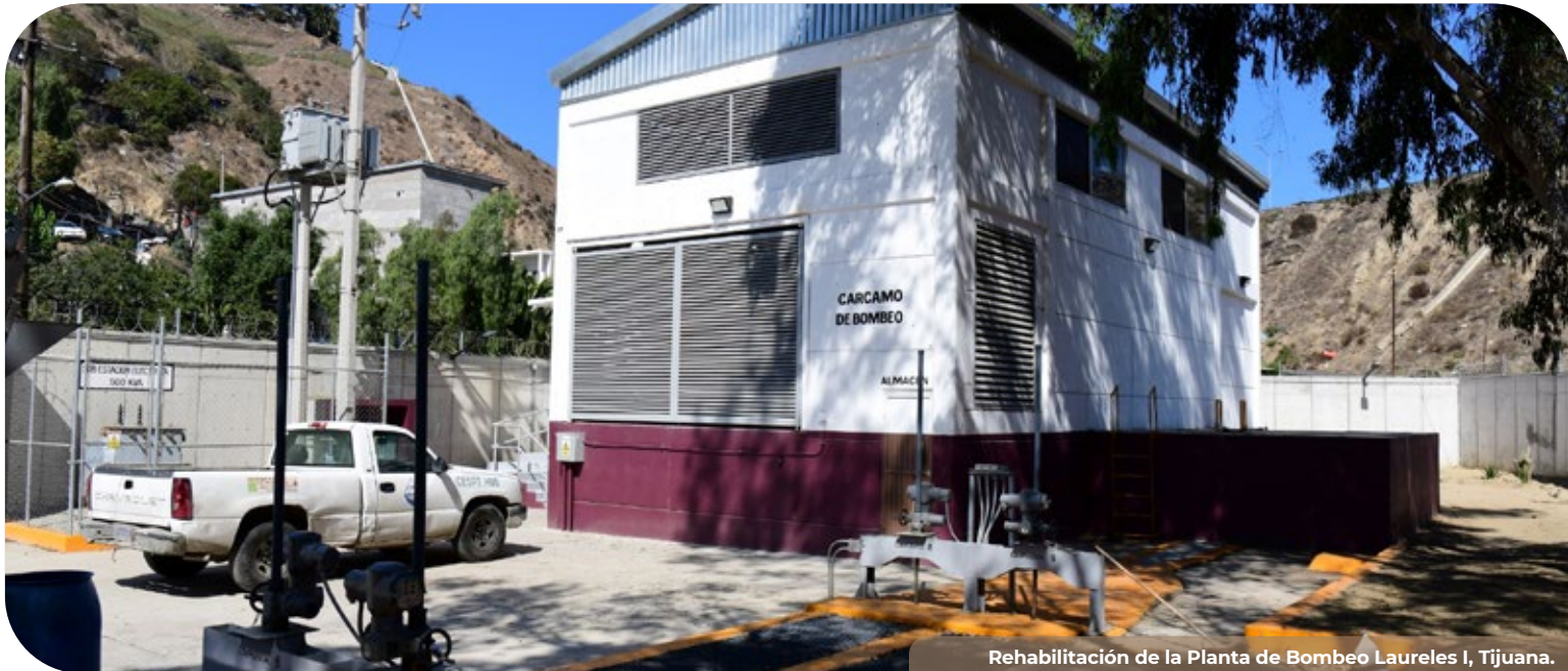
Rehabilitación de la Planta de Bombeo Laureles I, Tijuana.
